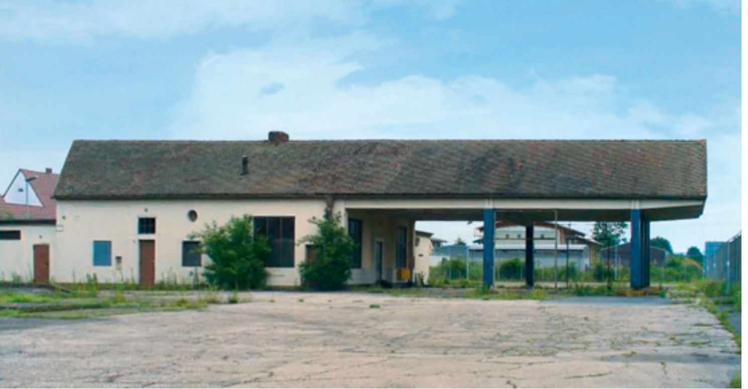
5 Heutiger Zustand der ehemaligen Reichsautobahntankstelle Mannheim-Seckenheim von Paul Schmitthenner, Nutzung als Werkhof für die Autobahnmeisterei, 2011.
