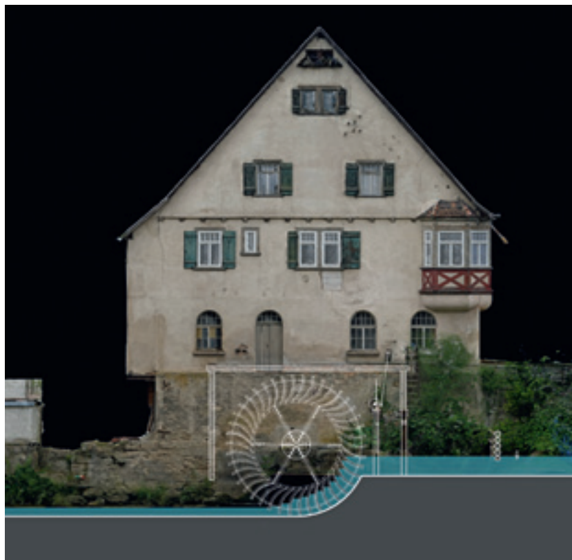
5 3D-fotogrammetrische Aufnahme der Kochlinsmühle mit Projektion des 1909 installierten Zuppigerrads von 580 cm Durchmesser innerhalb einer Radstube.
