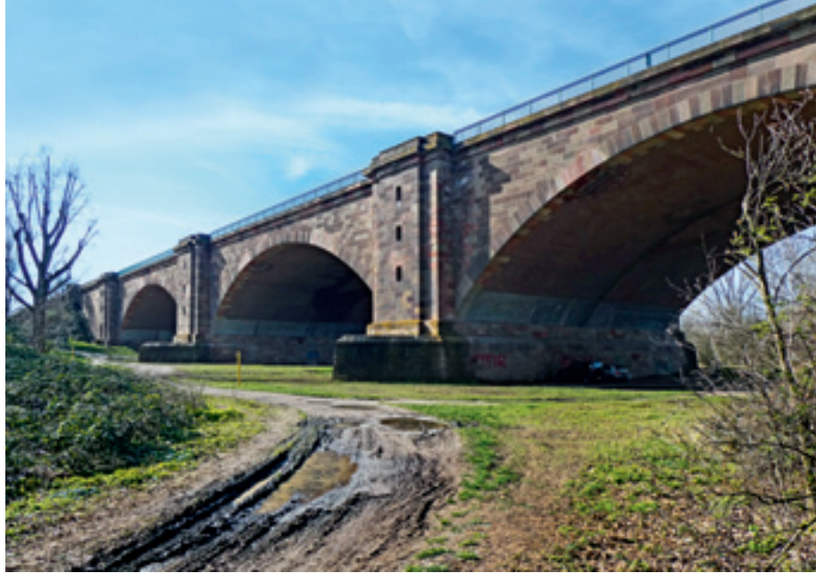
5 Autobahnbrücke Mannheim–Frankenthal 1940, Südwest-Ansicht 2020.
