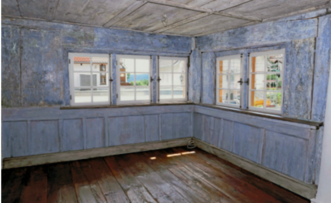
5 Die „Blaue Stube“: Wegen der geringen technischen und gestalterischen Qualität der auf Wand- und Brusttäfer aufliegenden Schichten war die Freilegung und restauratorische Sicherung der stabilen Erstfassung des 19. Jahrhunderts vertretbar. Die Holzfelderdecke ist nach Entfernen der Dispersionsfarbe wieder holzsichtig.
