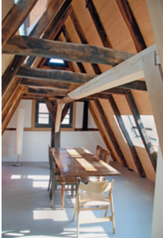
9 Das zweite Dachgeschoss mit dem in mittelalterlicher Zimmermannstechnik ergänzten Mittelunterzug. Zustand 2020.
