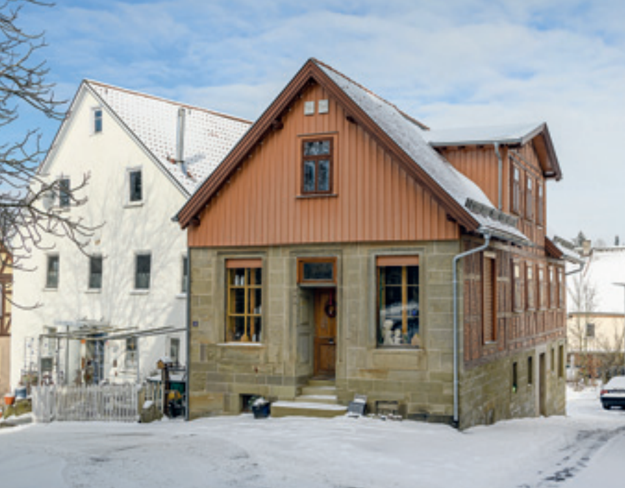
9 Ansicht von Süden mit Haupteingang und ehem. Ladengeschäft: Kirchgasse 18 in Kupferzell. Hinter dem Kaufladen befindet sich die zum Architekturbüro umgenutzte ehemalige Weinstube.
