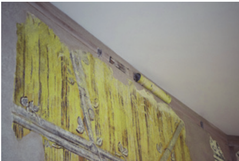
11 Detailaufnahme mit Zwischenzustand bei der Freilegung der Malerei.
