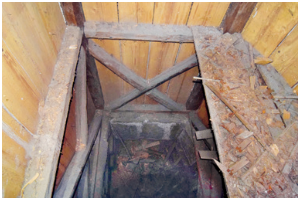
3 Blick nach Süden in den „Mittelsturm“ mit erhaltener bauzeitlicher Balken-/Lattenkonstruktion.
