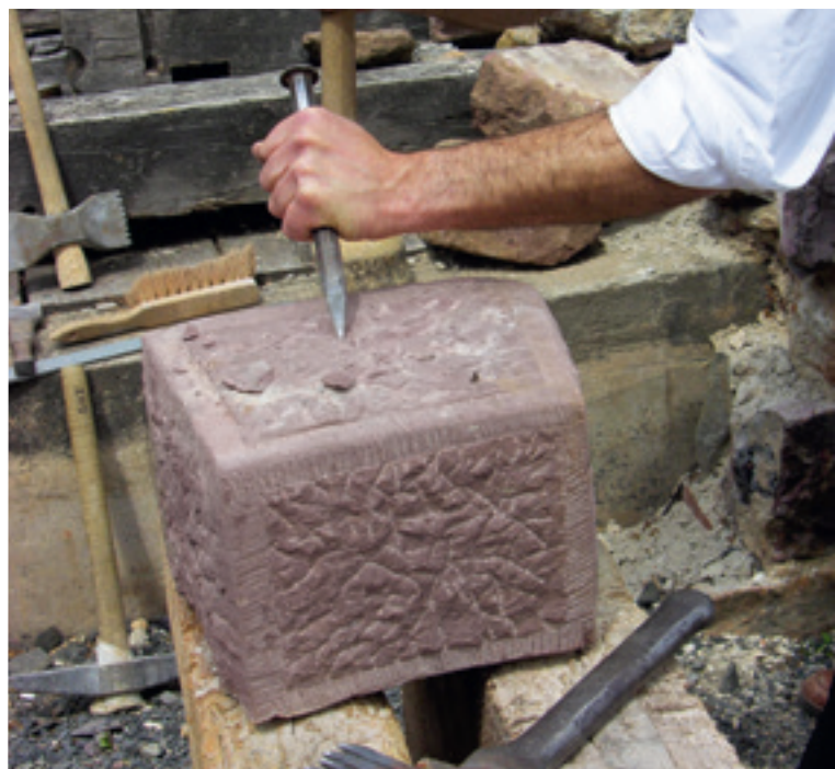
3 Bearbeitung eines Steinquaders mit traditionellem Werkzeug.
