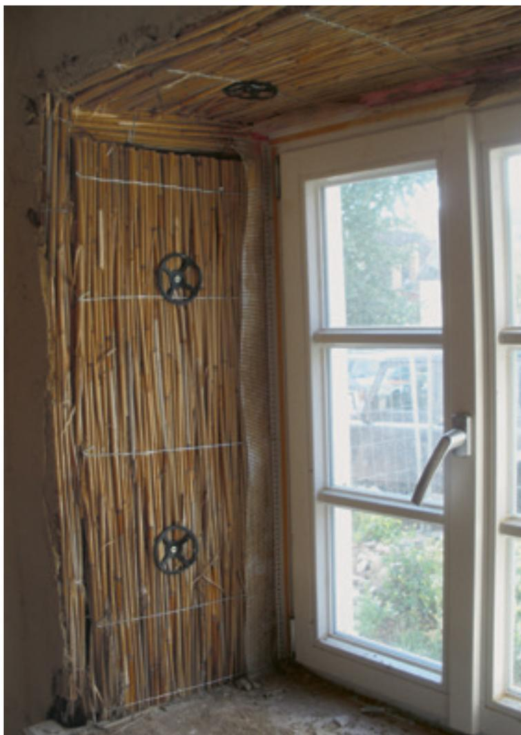
**6** Innendämmung aus Schilfrohmatten mit Lehmputz, 2014.
