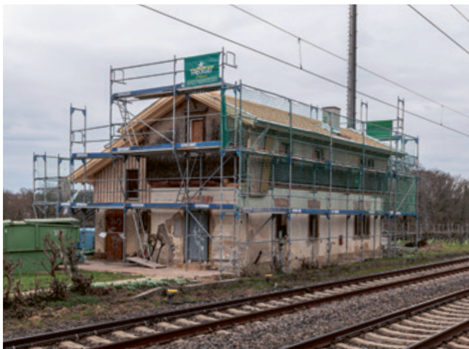
5 Bahnwärterhaus in Lauffen, Ansicht von Südwesten, 2023.
