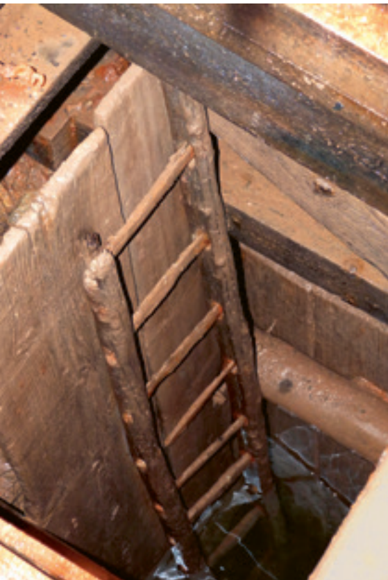
6 Haspelschacht auf der 6. Sohle der Grube Caroline; der Holzausbau stammt nach Dendrodaten an Eichen- und Tannenhölzern aus den Jahren 1528/30. Aufgrund des Einschusses im wassergesättigten Gesteinsschlamm sind sogar filigrane Hölzer perfekt erhalten, wie die Leiter von 1530 zeigt.
