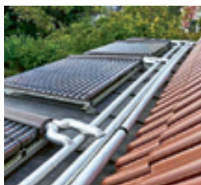
2 Solarthermie auf dem angeschiepten Süddach eines Wohnhauses.
