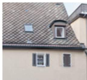
8 Betondachsteindeckung in Esslingen von 1896.
