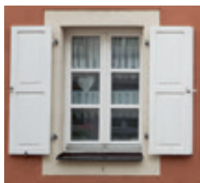
7 Zweiflügelige, sprossierte Holzfenster am Baudenkmal.
