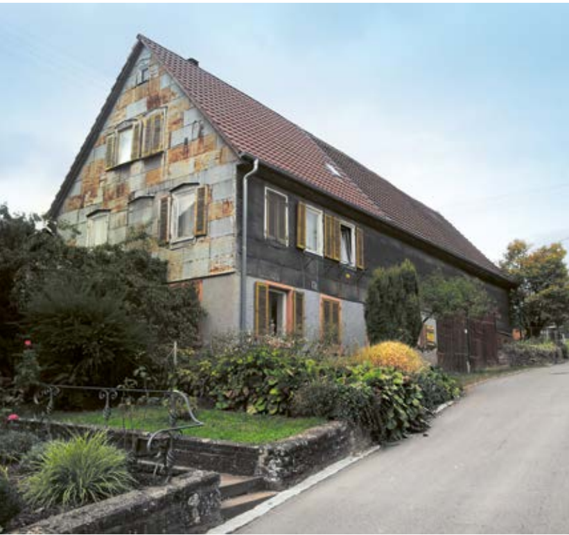
5 Wohnhaus der Familie Paulig in Birkenfeld-Oberhausen, ehemalige Knopffabrik von 1896, vor der Sanierung.
