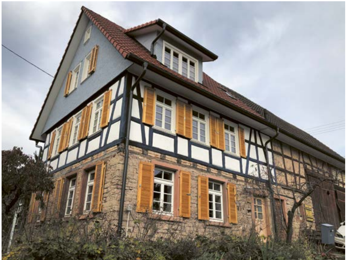
6 Wohnhaus der Familie Paulig nach der Sanierung. Das Gebäude gilt als besonders erhaltenswerte Bausubstanz.
