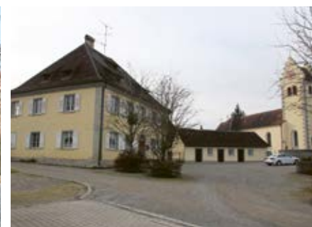
5 Pfarrhaus in Deggenhausetal-Urnau.
