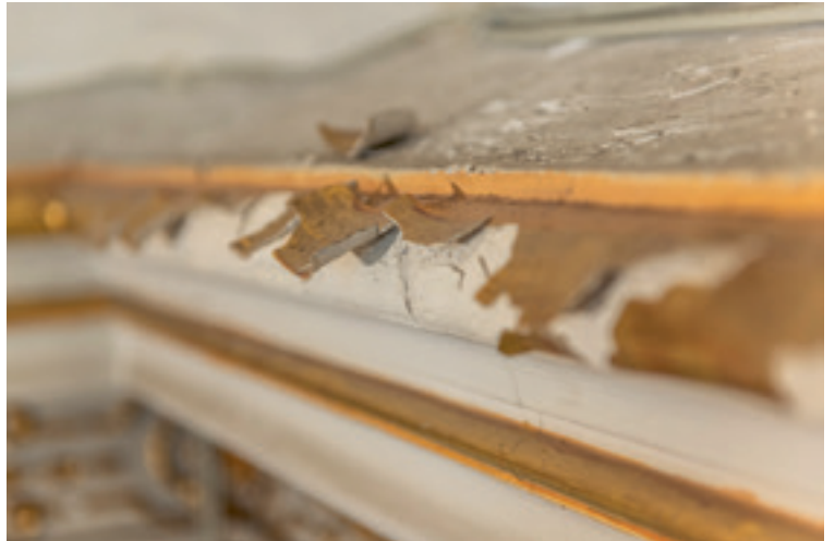
6 Detail aufstehende Metallaufgabe in Raum 137.
