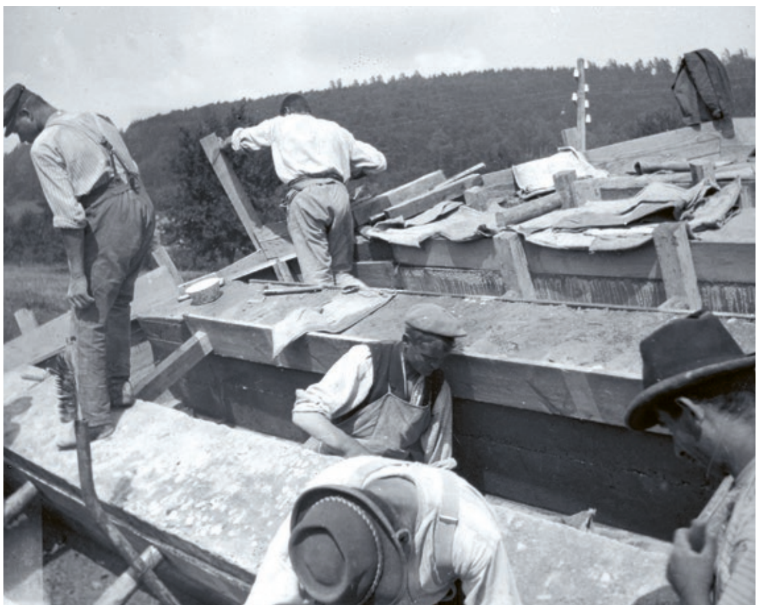
3 Arbeiter auf und zwischen den zuerst betonierten Lamellen.
