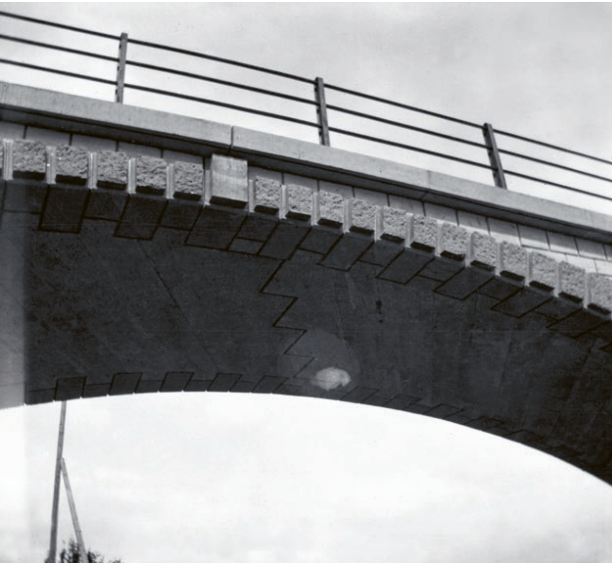
4 Untersicht der Stahring- er Brücke mit treppen- förmiger Gelenkfuge im Brückenscheitel.
