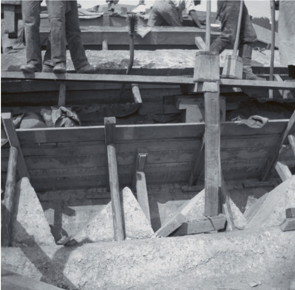
6 Treppenförmige Anordnung der Gelenkflanken.
