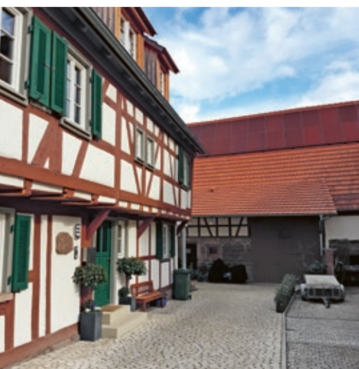
10 Rote Aufdach-PV-Anlage auf der hofseitigen Dachfläche einer Scheune in Mühlacker-Lienzingen (14. 5. 2025).
