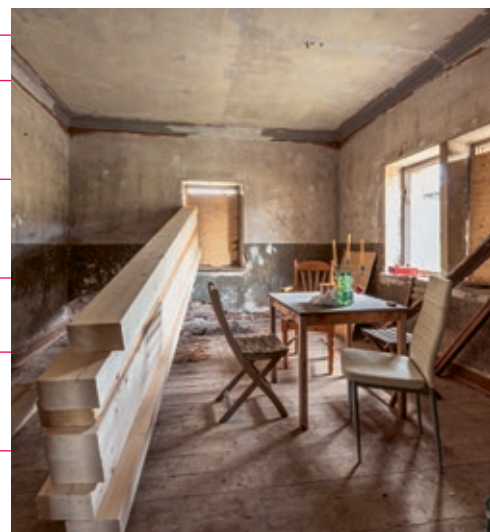
9 Wohnen im Kulturdenkmal – Baustellenimpression (12. 3. 2025).
