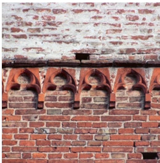
3 Formsteinfries an einem Backsteinturm (9. 4. 2025).
