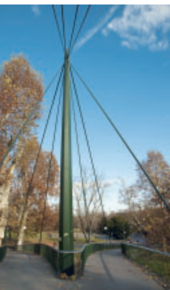
6 Ferdinand-Leitner-Steg mit Fußgängertrasse, Pylon und Drahtkabelbündel, 2009.
