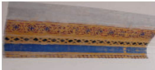
Mithilfe einer Schablone Ende des 19. Jahrhunderts aufgemalter Fries in einem der Räume.
