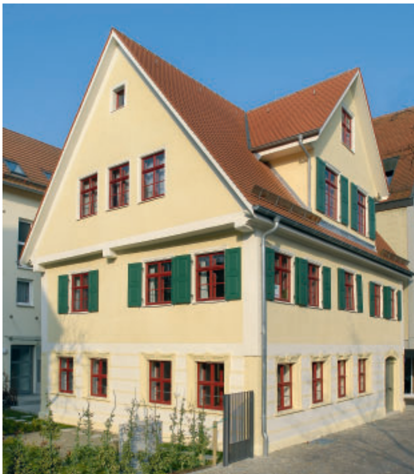
Ansicht von Südosten, Zustand nach der Instandsetzung mit restauratorisch nachgewiesener Farbfassung der prägenden barocken Umgestaltung von 1776.
