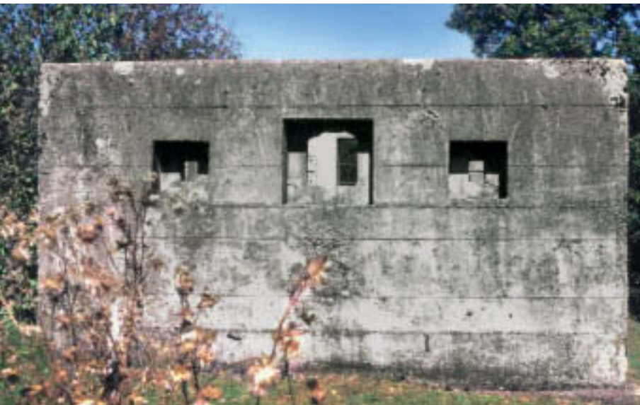
5 Sperrstelle an der Bundesstraße bei Karsau, Stadt Rheinfelden, 1936.
