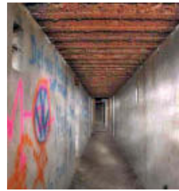
3 Hohlraum eines Stollensystems der Neckar-Enz-Stellung in Unterriexingen, 1936.
