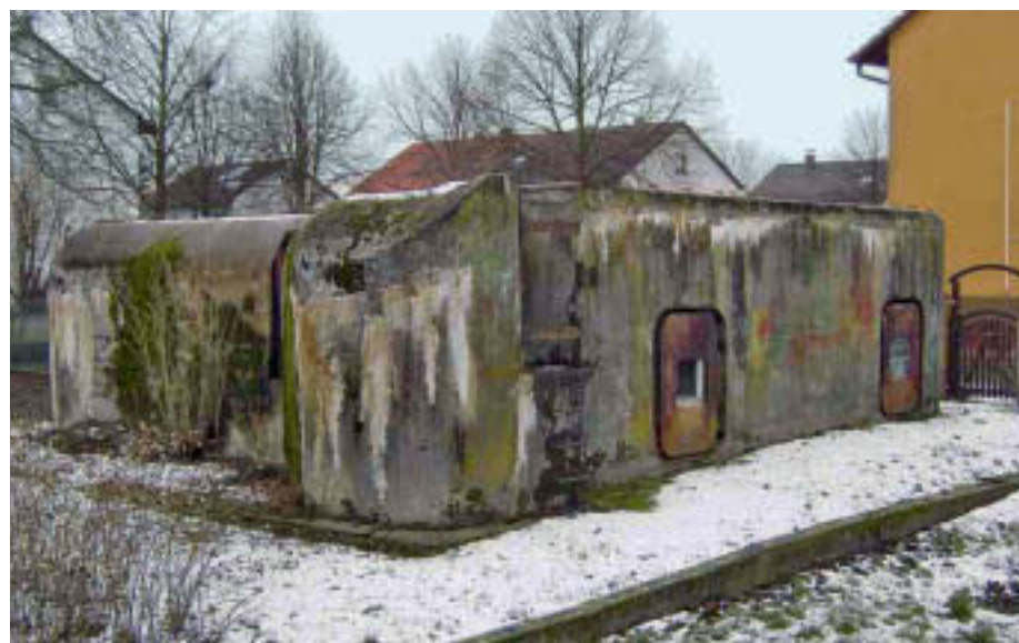
4 Einst als Holzschuppen getarnt: Unterstand in Durmersheim, 1936.
