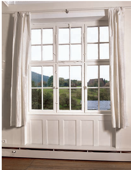
1 Instandgesetztes historisches Fenster, ehemaliger Schulsaal im ersten Obergeschoss.
