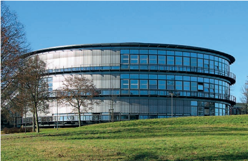
15 Rottweil, Berufsschulzentrum. Die komplette Verglasung besteht aus Vertikalschiebefenstern.
