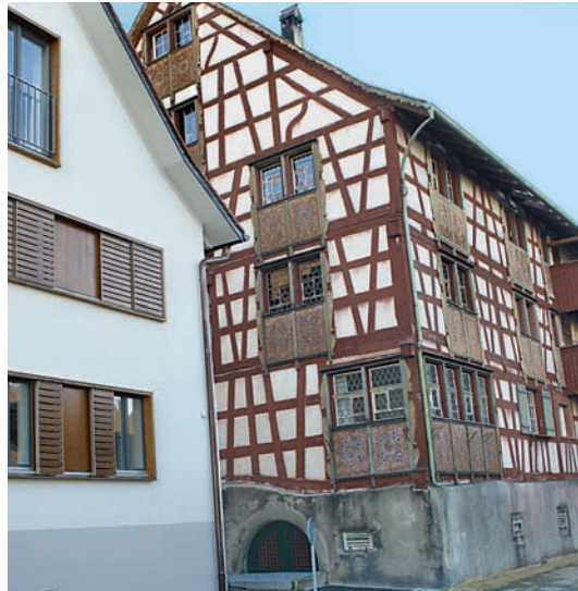
10 Ermatingen, Kehlhof (Schweiz): Auch an dem danebenliegenden modernisierten Gebäude wurden „Fensterwagen“ mit horizontal laufenden Schiebeläden in moderner Ausführung eingesetzt.
