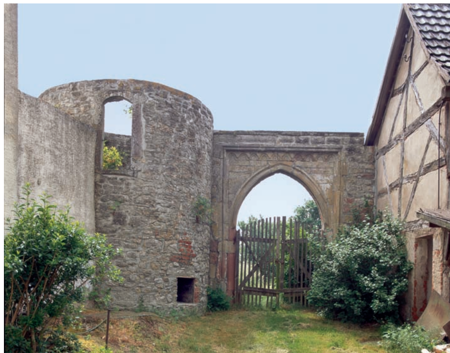
3 Rundturm mit dem vermuteten Westportal der Klosterkirche.
