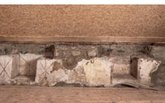
11 Erdgeschoss des Ostflügels, vermutlich der Kapitelsaal. Aufnahme 1995 vor Beginn der Sanierung.
