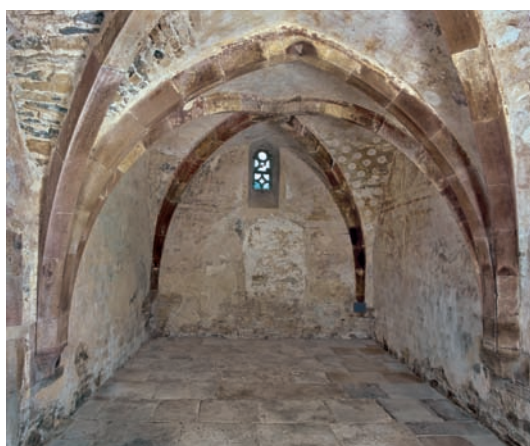
7 Blick in die Sakristei.
