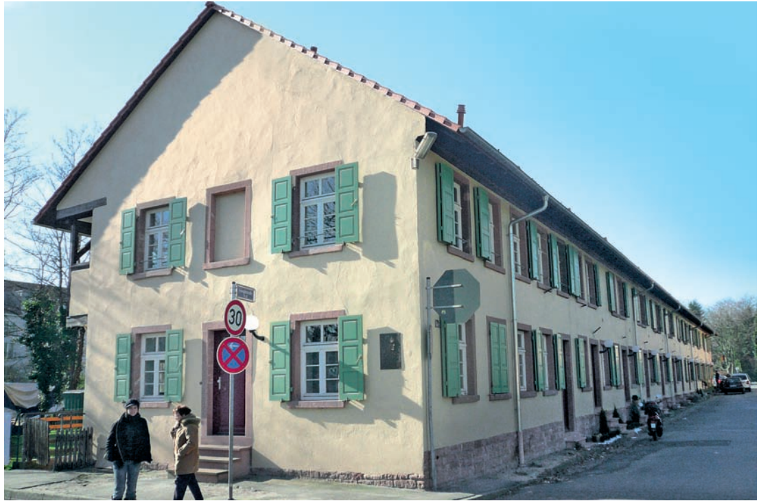
1 Mannheim-Luzenberg, Spiegelkolonie, straßen- seitige Ansicht des erhaltenen Reihenbaus nach der Sanierung.
