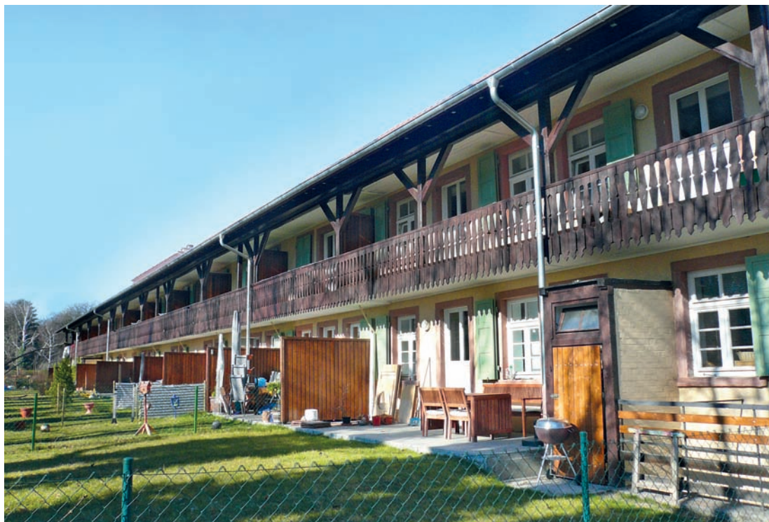
2 Mannheim-Luzenberg, Spiegelkolonie, Gartenseite mit Laubengang des erhaltenen Reihenzuges nach der Sanierung.
