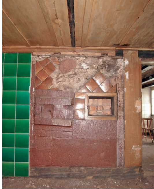
2 Ofenwand zur Küche mit Lichtofen (hier mit dem Blechschieber verschlossen) und der ehemaligen Durchreiche.
