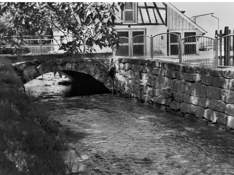
2, 3 Der Krebsbach in Eigeltingen, 1999. Die Bachbetteinfassung mit Sandsteinquadern und die Sandsteinbogenbrücken sind ebenso Bestandteile der denkmalgeschützten Sachgesamtheit wie die über dem Bach errichteten Gemeindevaschhäuser.
