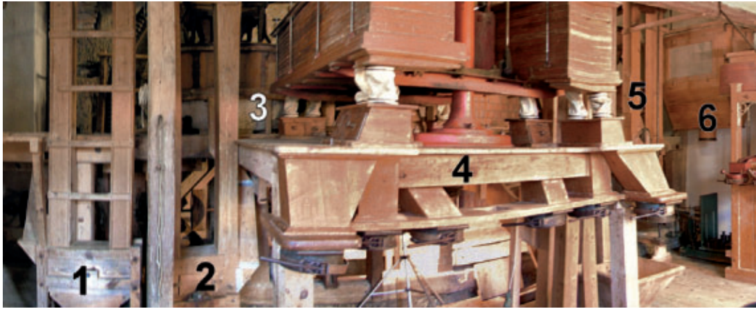
3 Panorama im Hauptraum des Erdgeschosses: Elevator zum Trommelsieb (1), Champagnergang (2), Elevator zum Plansichter (3), Plansichter (4), Elevator beim Gerbgang (5), Gerbmachine (6).
