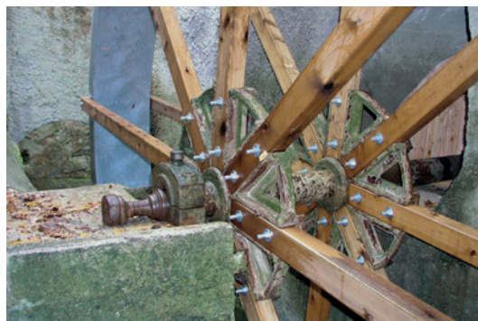
9 Zustand vor Beginn der Rekonstruktion des Mühlrades. Der Mühlenbauer Andreas Düntzsch prüft mit dem Senklot die Einbausituation der Armsterne.
