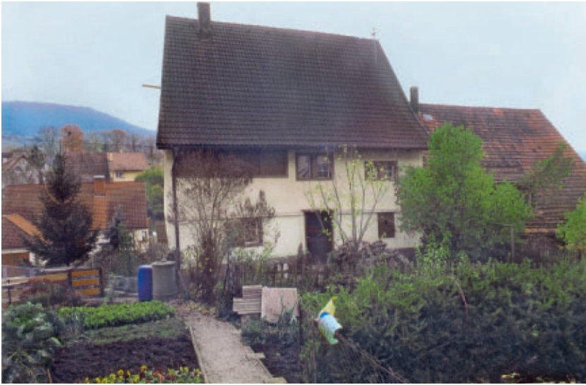
4 Ansicht der Gartenfassade vor Beginn der Instandsetzungsmaßnahmen; im Obergeschoss der ehemalige Abortgang mit Schiebeläden.
