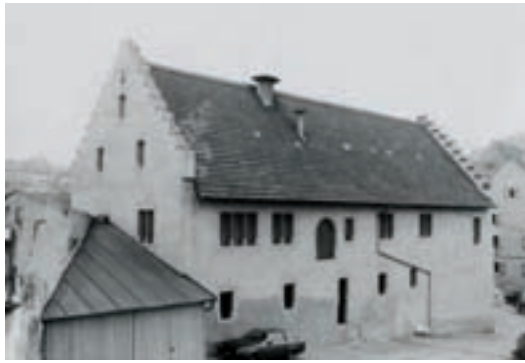
11 Der Haberhauskasten von der Hofseite mit den repräsentativen Fenstern und der Türe im Obergeschoss, um 1990.
