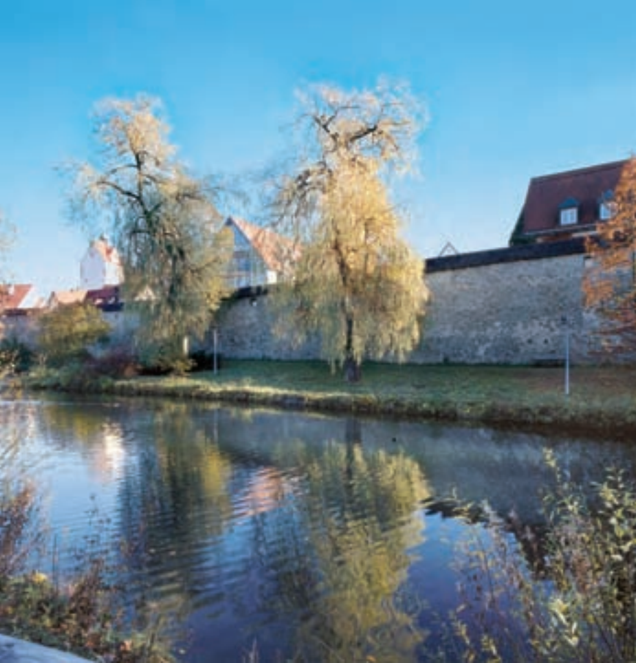
2 Untere Stadtmauer, Stadtaußenseite, Blick vom Grabenweg vor Beginn der Maßnahmen.
