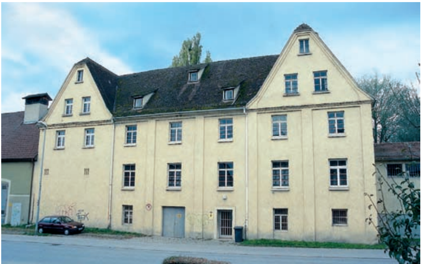
1 Rottenburg a. N., Vorderfront des Hauses Gartenstraße 70, Blick von Nordosten im Herbst 2006.
