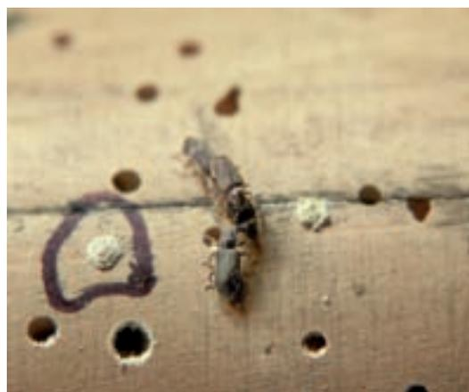
1 Bohrmehlhäufchen mit Krater und Schleifspuren auf einem Dielenboden.
