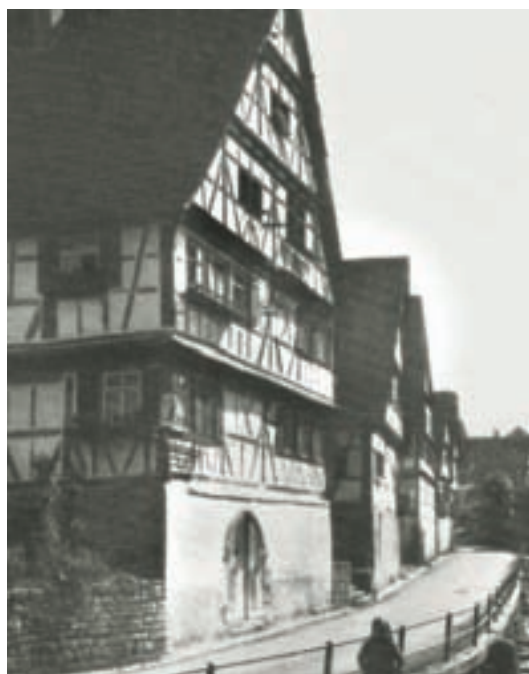
4 Giebelständig gereichte Weingärtnerhäuser des 16. bis 18. Jahrhunderts in Weinstadt-Strümpfelbach (Rems-Murr-Kreis), Foto 1920 vor der Verdoelung des Bachs.
