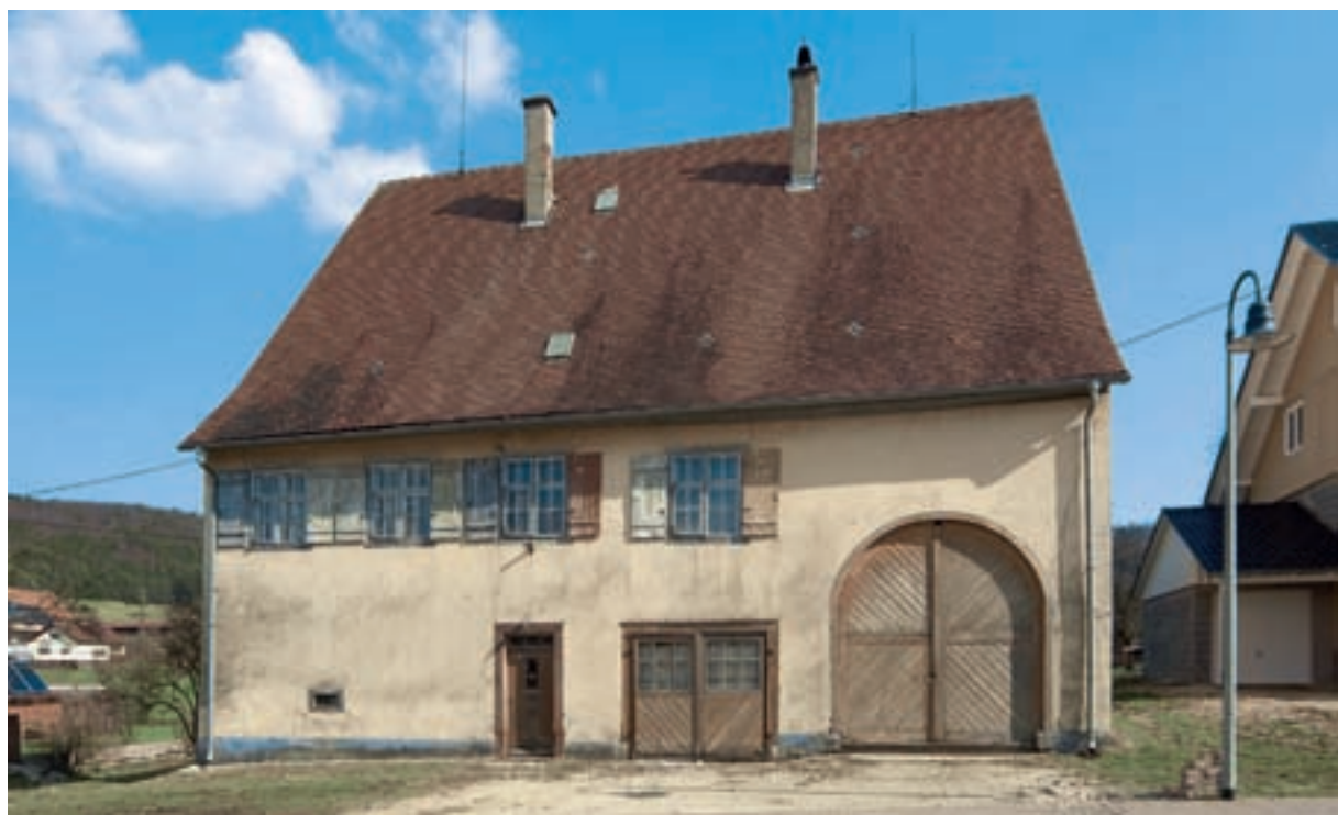
1 Straßenfassade vor der Maßnahme 2005.
