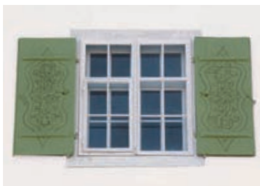
3 Giebeldetail mit bauzeitlichem Fensterladen samt Schablonenmalerei.
