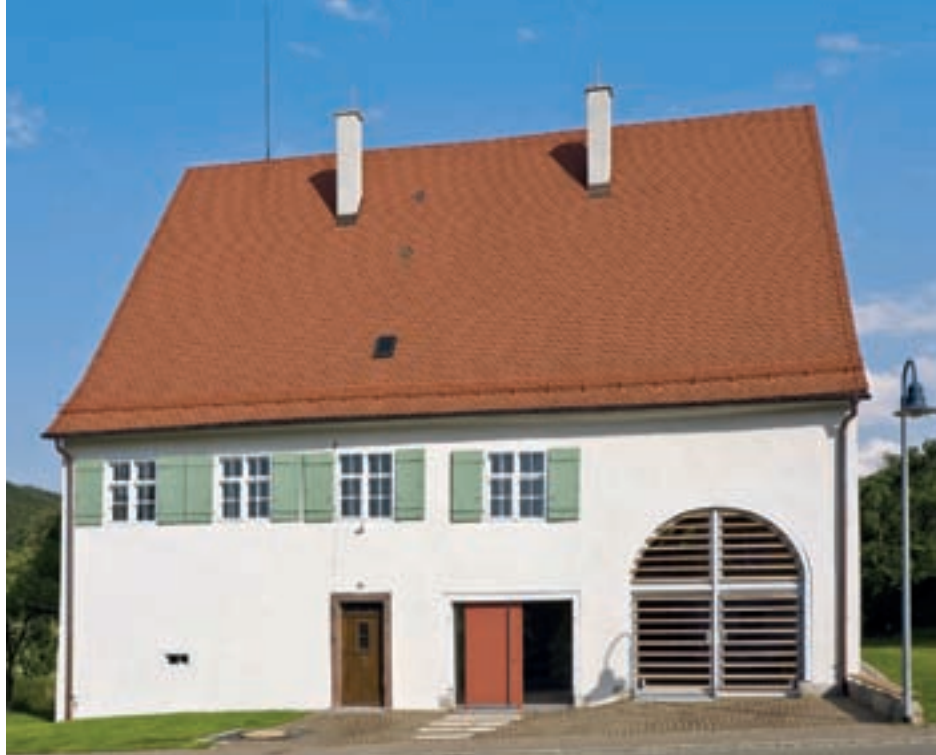
2 Straßenfassade nach der Instandsetzung 2007.
