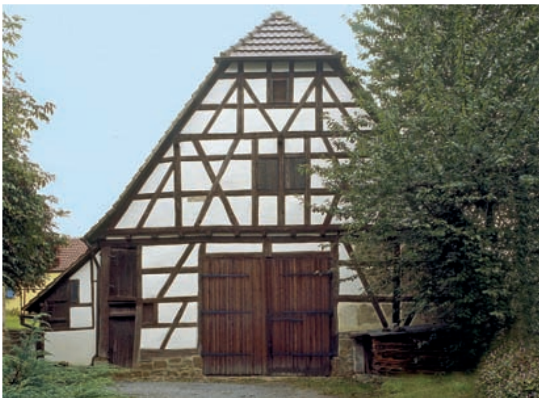
2 Ackerbürgerscheune Schlossgasse 8 von der Hofseite, Zustand 2007.
