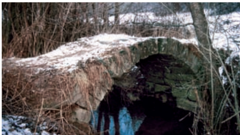
21 Brücke, Oberstenfeld, LB.
