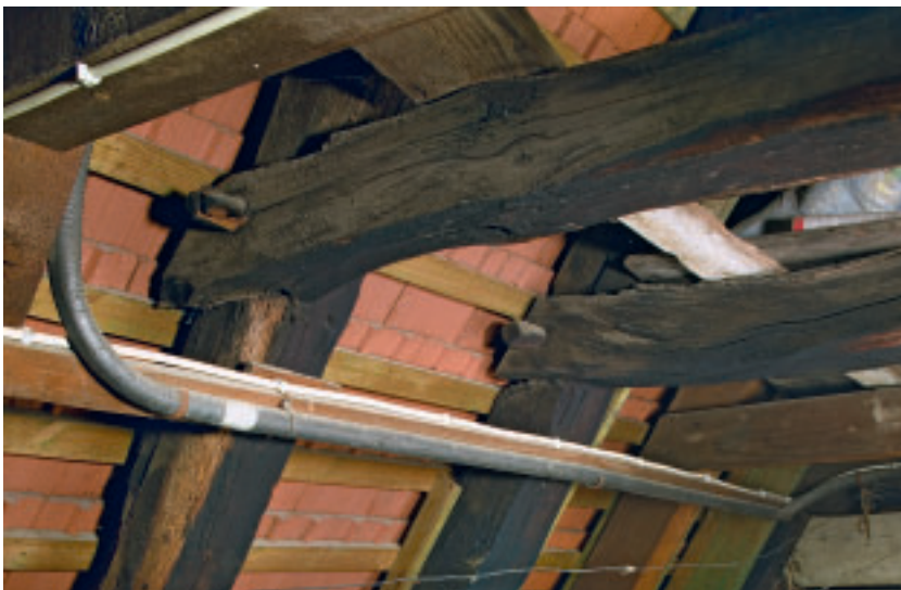
2 Badgasse 1: Verblatung von Kehlbalken und Sparren im Dach von 1360.
