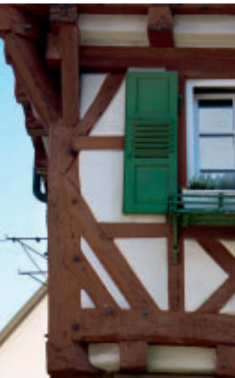
13 Hauptstraße 42: Winkelholz mit Verblattung oben und Verzapfung unten.
