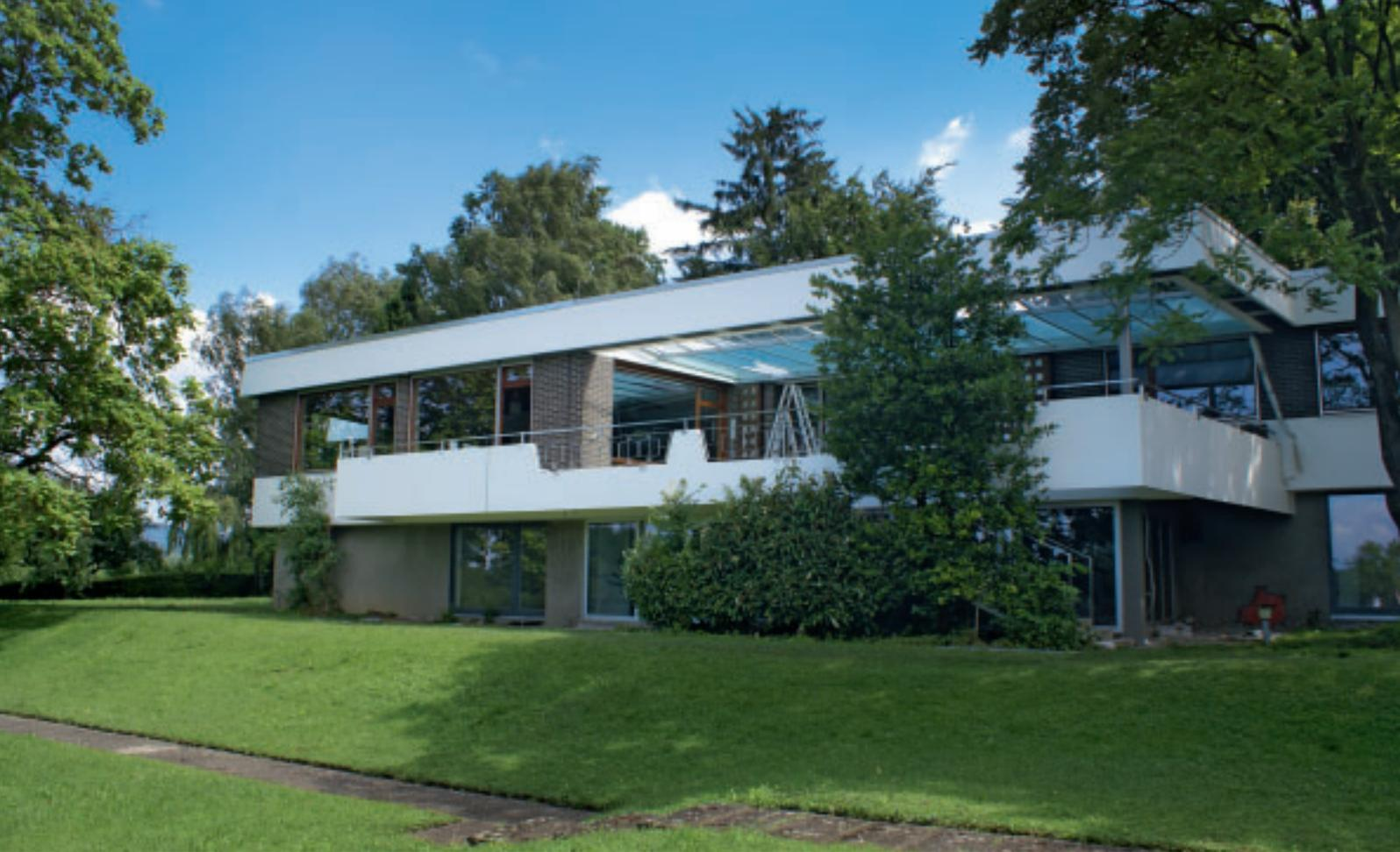
2 *Das Farbkonzept beruht auf der sorgfältig aufeinander abgestimmten Materialwahl: Das Weiß des Betons, das Braun des Klinkers, das Silbergrau der Kalksteinplatten, des Edelstahlgeländers und der geschliffenen Betonbrüstung ergänzen sich mit dem Blaugrün des Glasdachs zur modernen eleganten Gesamtwirkung.*
