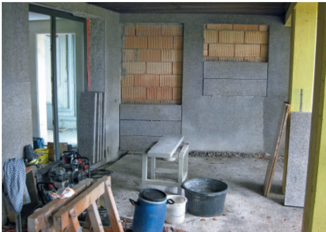
10 Während der Montage der Waschbetonelemente im leicht umgebauten Erdgeschoss.
