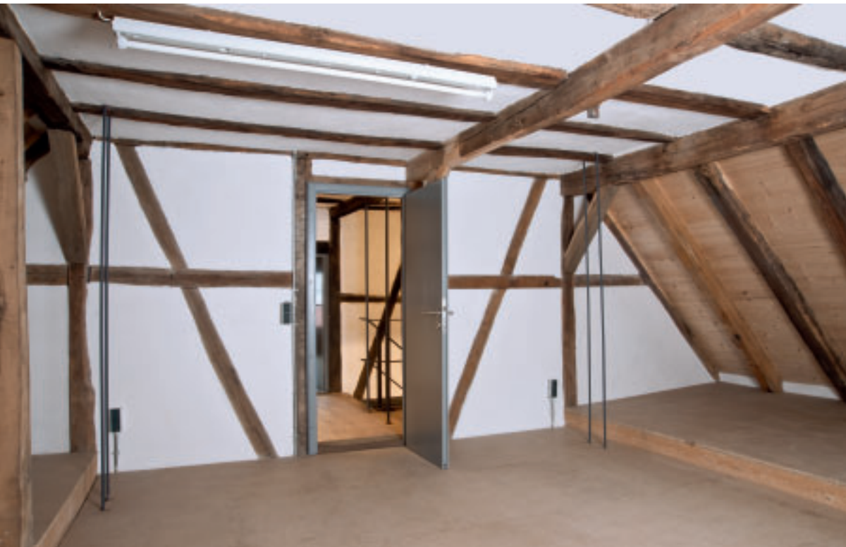
9 Dachraum nach Instandsetzung und Ertüchtigung der Dachkonstruktion, Ende 2010.
