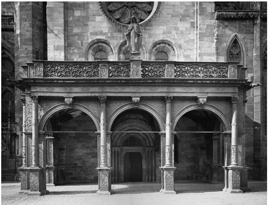
2 Historische Aufnahme der Vorhalle, um 1880.
