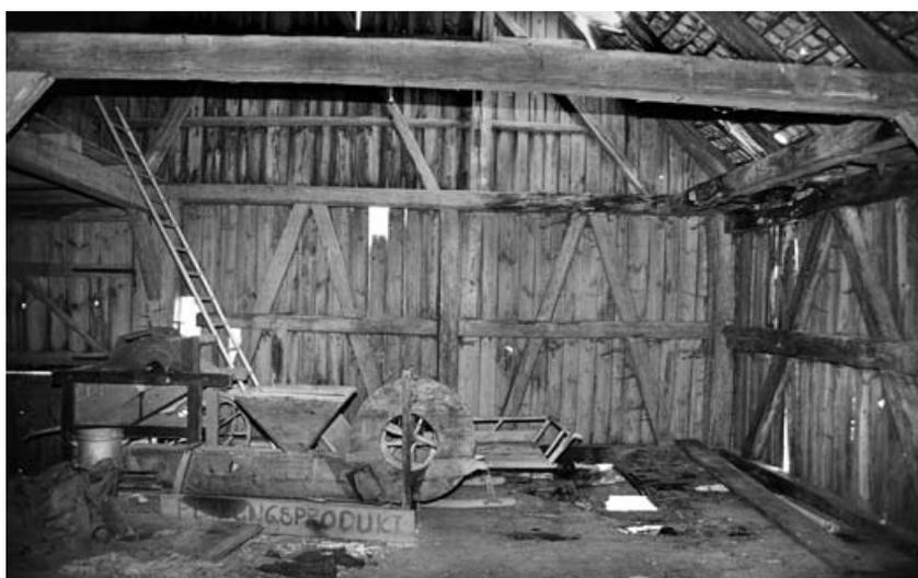
9 Die Durchfahrtstenne der Scheuer vor der Instandsetzung. Rechts ist die ursprüngliche Außenwand in Vollholzkonstruktion zu erkennen. Der Boden war irreparabel geschädigt.
