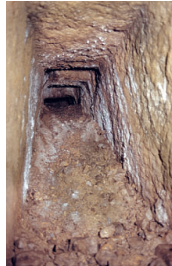
8 Mit Bergen teilweise zugesetzter Querschlag nach Nordosten.
