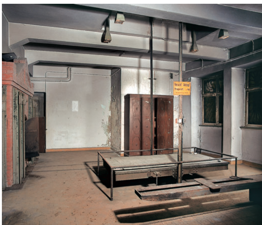
11 Ofenraum im Untergeschoss, Sargaufzug, Dezember 2004.
