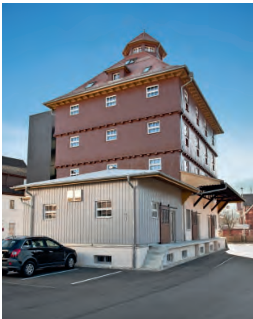
4 Lagerhaus von Nordwesten, Zustand 2012. An der Westseite befindet sich die Laderampe mit einstigem Gleisanschluss. Die Nordfassade mit ehemaligem Kunstdüngerschuppen blieb unverändert.
