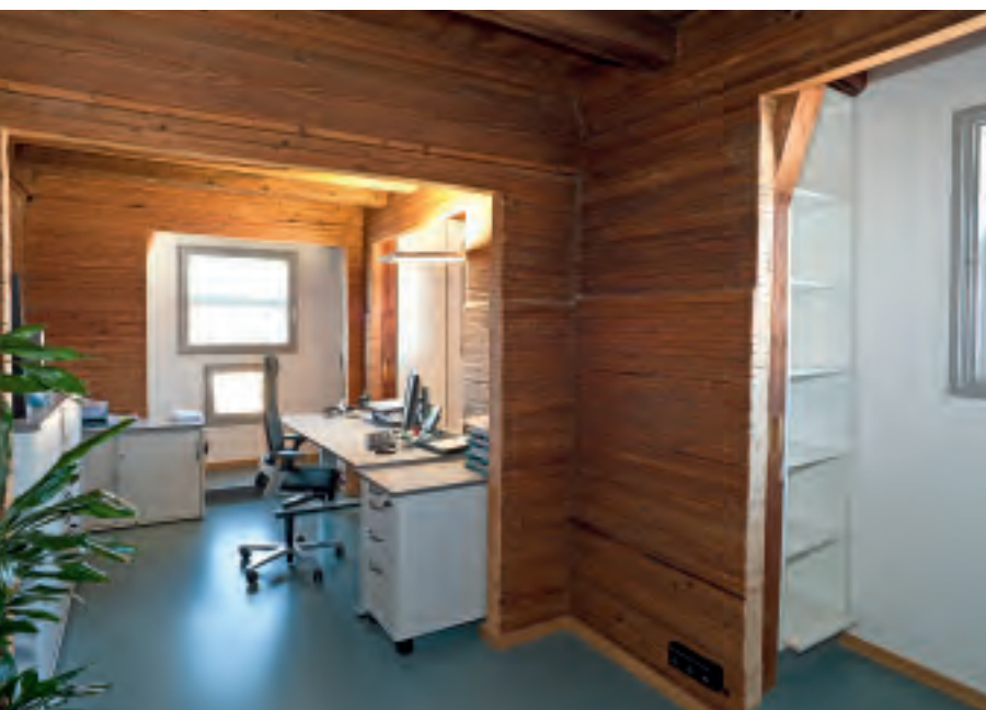
11 Büro im nördlichen Teil (ehem. Silobereich) des dritten Obergeschosses mit als Wandschrank genutzter Nische zwischen Silowand und Außenwand.
