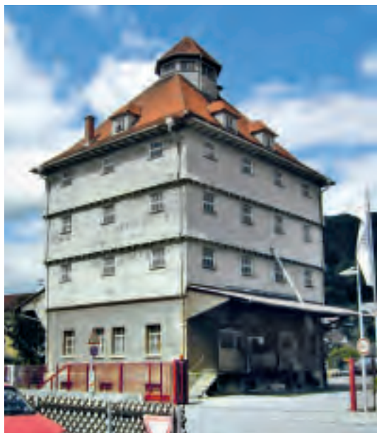
2 Lagergebäude von Südosten, Zustand 2005.
