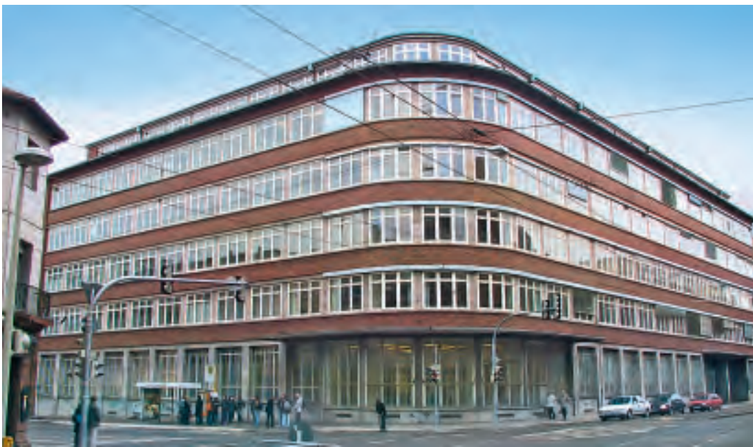
13 Stuttgart, Seidenstraße, ehemaliges Bosch-Verwaltungsgebäude. Das Erdgeschoss besitzt noch die bauzeitlichen Metallverbundfenster.
