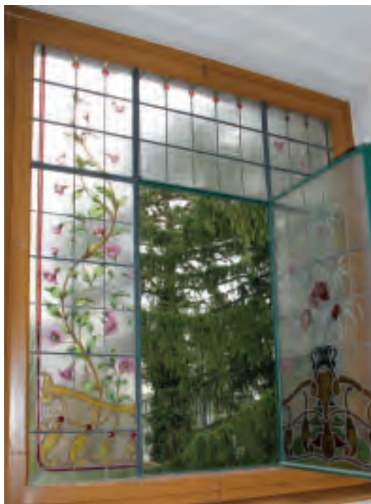
17 Frauenfeld, Ringstraße. Die Bleiverglasung mit Stahlrahmen und -flügel ist in ein Holzfenster eingebaut.
