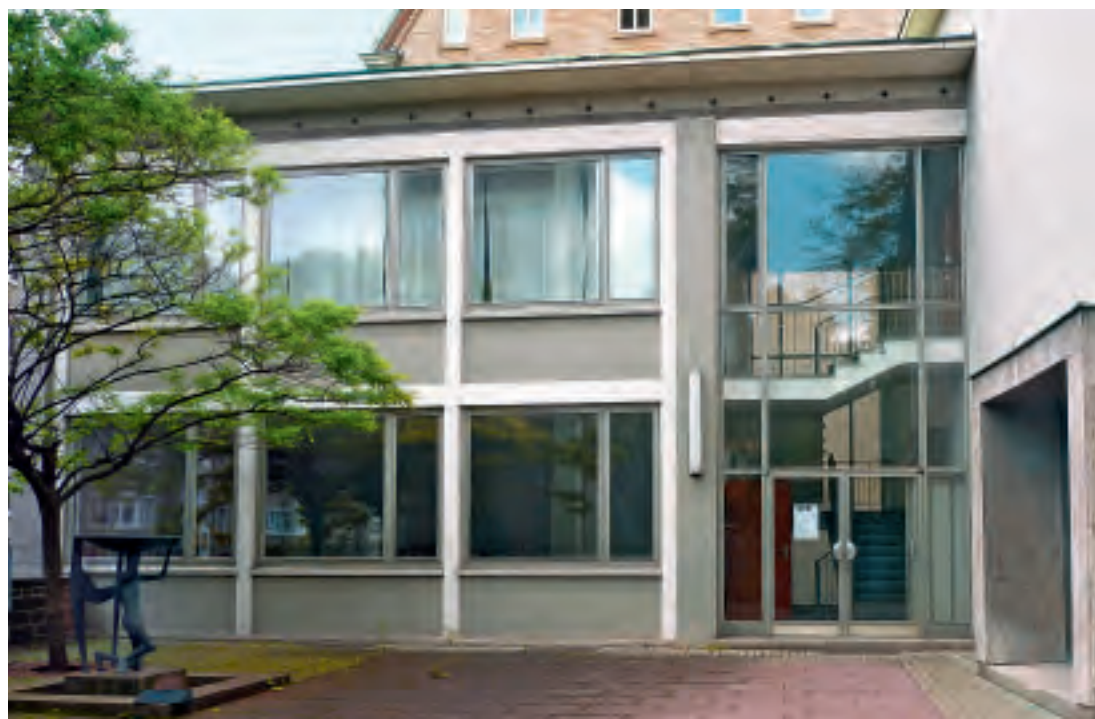
19 Stuttgart, Rosenbergstraße, Konfirmandengebäude der Rosenberkkirche. Die Fassade der fünfziger Jahre wird von filigranen Stahlfenstern mit Wendeflügeln geprägt.
