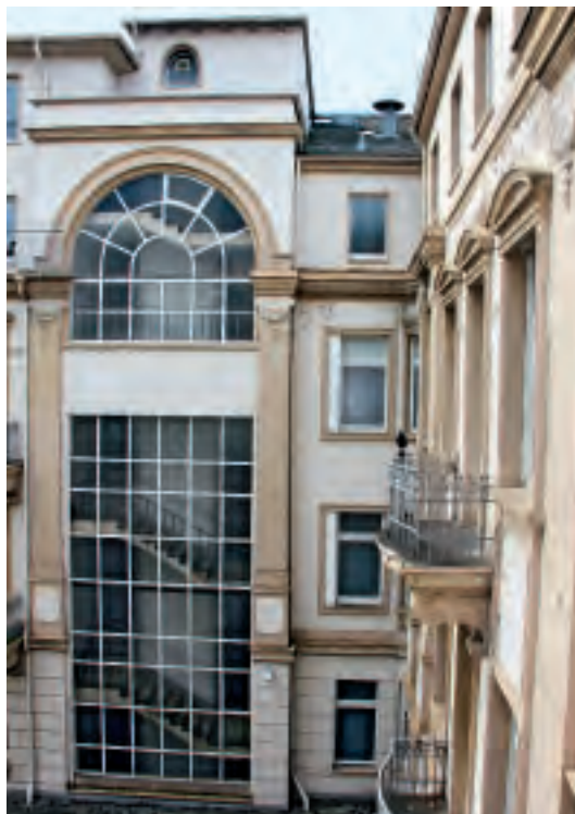
1 Wiesbaden, Konrad-Adenauer-Ring. Mehrgeschossiges Treppenhausfenster aus Walzprofilen, filigran und stabil.
