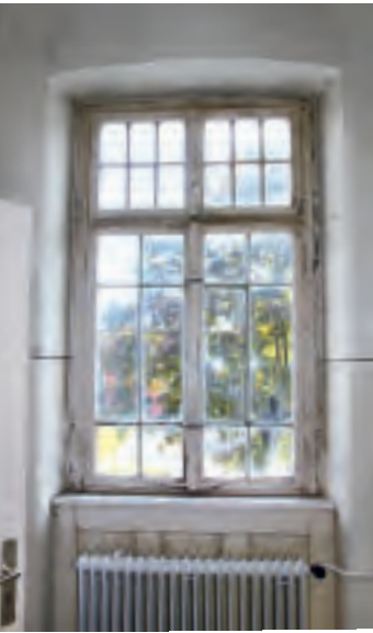
5 Wiesloch, Psychiatrisches Landeskrankenhaus. Die Sprossierung der Holzfenster bestand aus Sicherheitsgründen aus Stahlprofilen.
