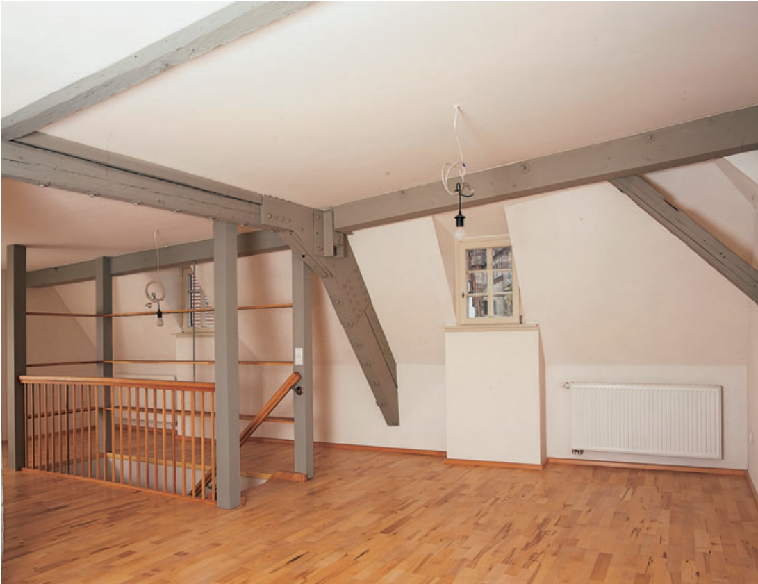
8 Innenansicht, Dachgeschoss nach dem Ausbau, 2002.
