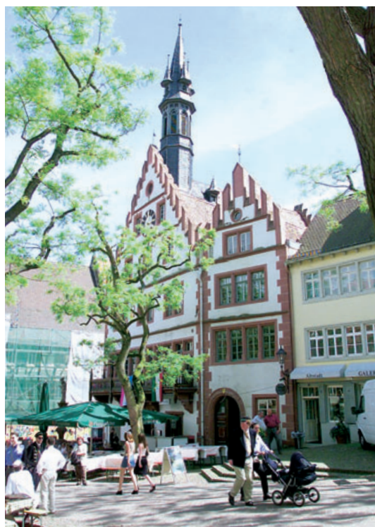
5 Marktplatz 1 und 3 (Altstadtgalerie); im Keller des Gebäudes Marktplatz 3 befindet sich die „Energiezentrale“, die im Verlauf des zweiten Bauabschnitts installiert wurde.
