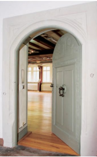
1 „Willkommen im Bürgersaal“, Blick vom Treppenhaus auf die Saaltür mit Holzornamenten.
