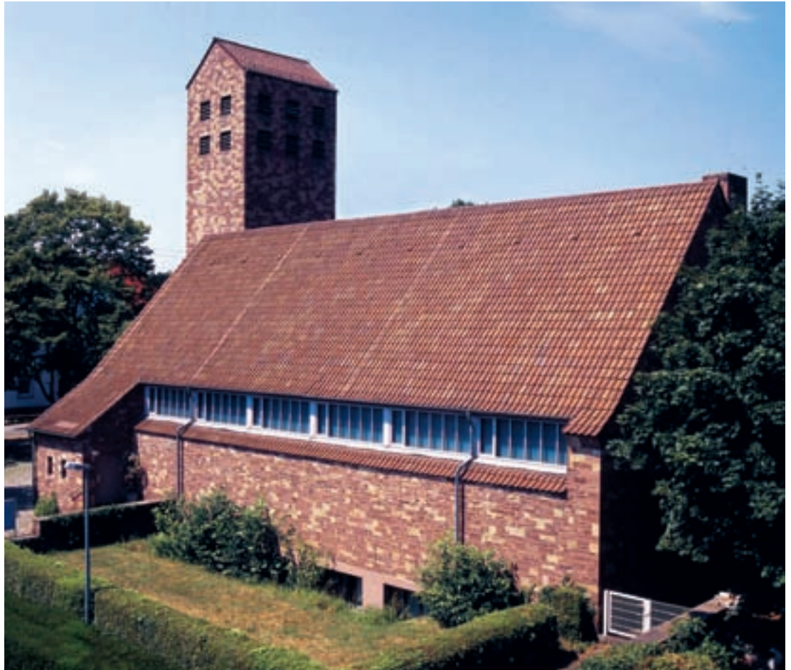
14 Die Friedenskirche in der Karlsruher Tauberstraße. In den 1960er Jahren gab man den seitlichen Haupteingang zugunsten einer zentralen Erschließung auf. Zustand 2005.
