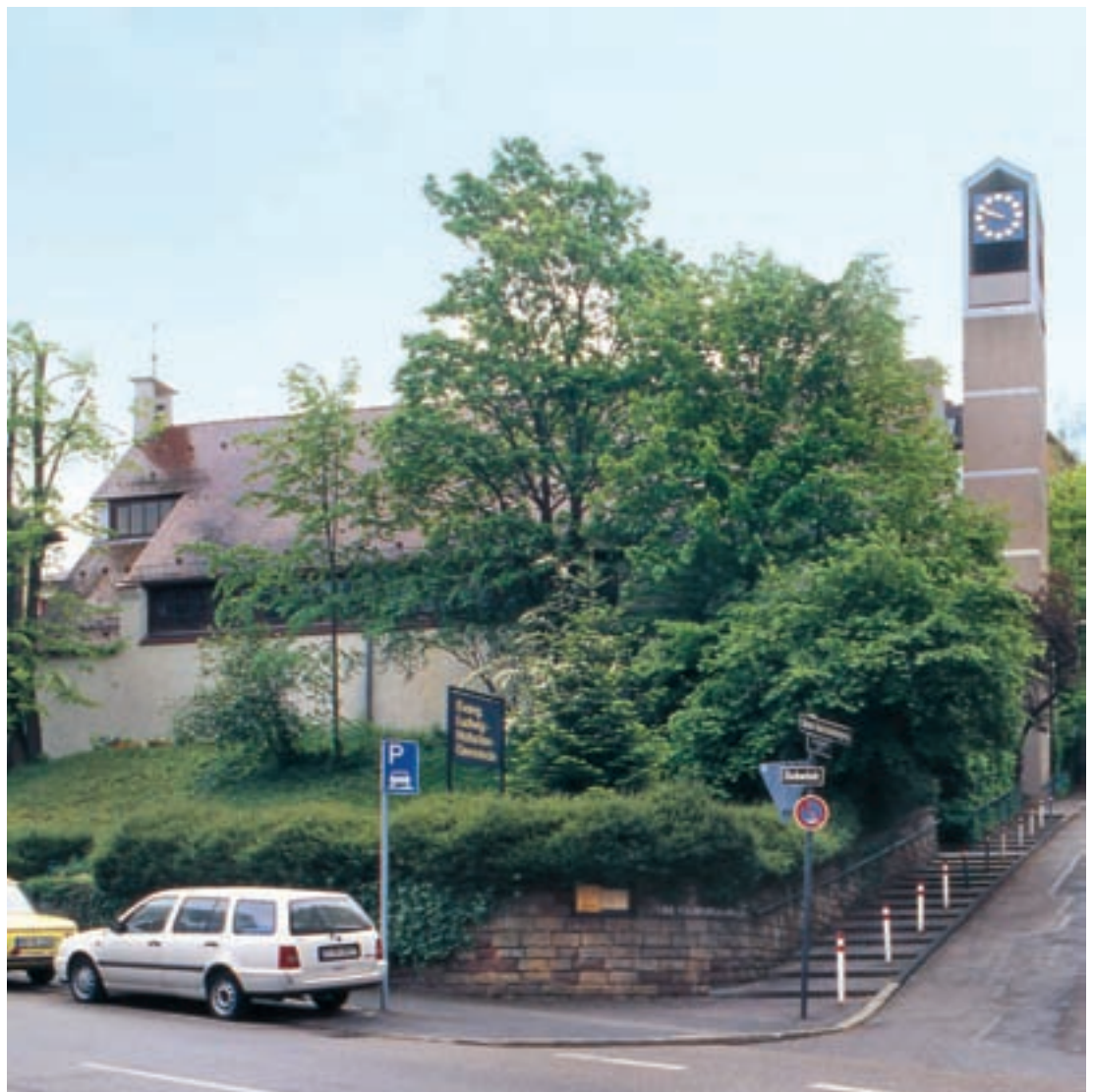
16 Die Stuttgarter Ludwig-Hofacker-Kirche in der Dobelstraße. Zur Bauzeit lediglich mit einem Dachreiter ausgeführt, ergänzte man die Notkirche um 1960 durch einen frei stehenden Glockenturm. Die Fassaden wurden verputzt. Zustand 2005.
