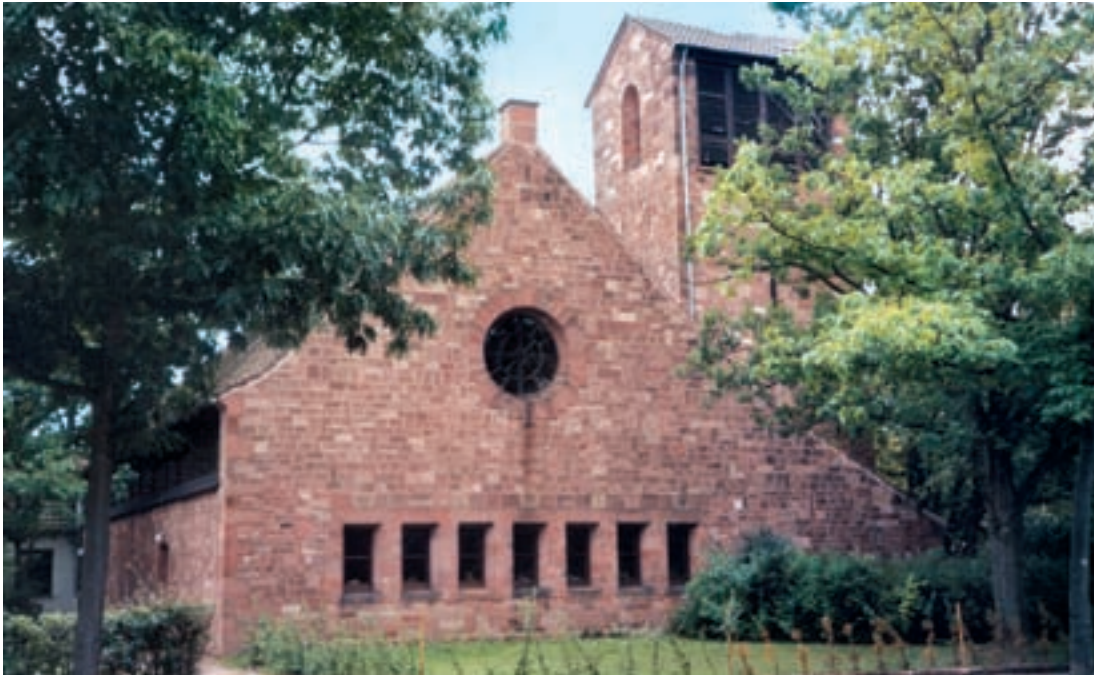
12 Die Mannheimer Gnadenkirche in der Karlsternstraße wurde bereits in den 1950er Jahren durch einen seitlichen Turmanbau ergänzt. Zustand August 2004.
