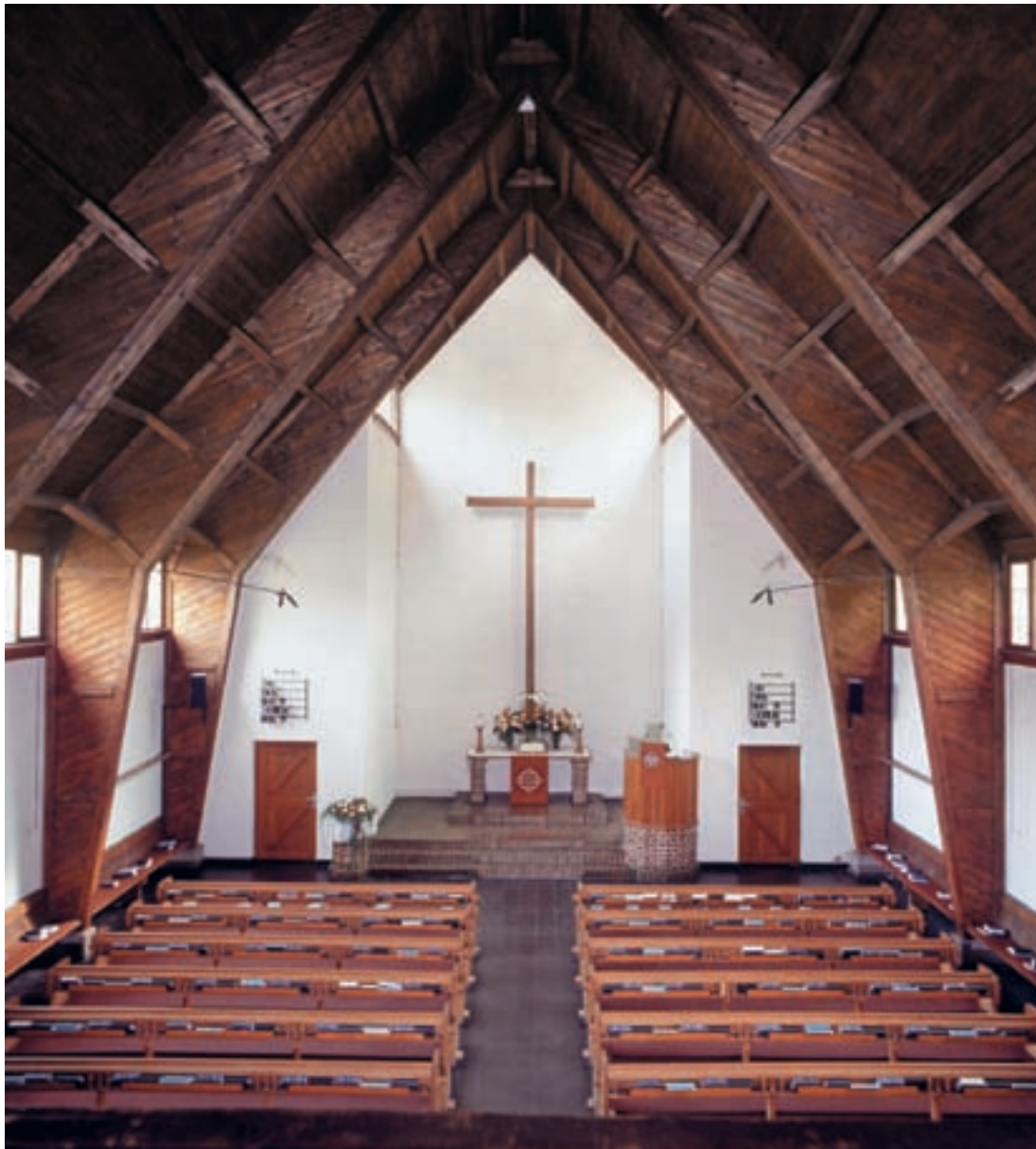
17 Die Stuttgarter Notkirche führte man als Typ B mit gemauertem Altarraum aus. Man nimmt an, dass die Wandflächen im Innenraum bereits zur Bauzeit weiß geschlämmt wurden. Abgesehen von geringfügigen Veränderungen ist der Kirchenraum einschließlich der seriellen Ausstattungsstücke original überliefert. Zustand 2005.
