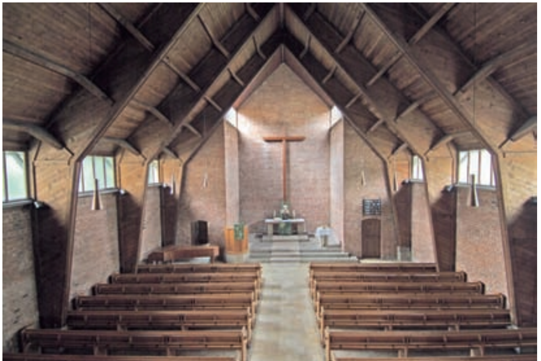
11 Die Wichernkirche in Heilbronn ist abgesehen von neuen Pendelleuchten einschließlich ihrer Ausstattung original überliefert. Sie wurde als Typ B mit gemauertem Altarraum ausgeführt. Zustand 2005.
